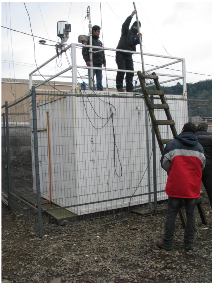
Reparación Antena Telescópica EMCA M. Ferroviario.
